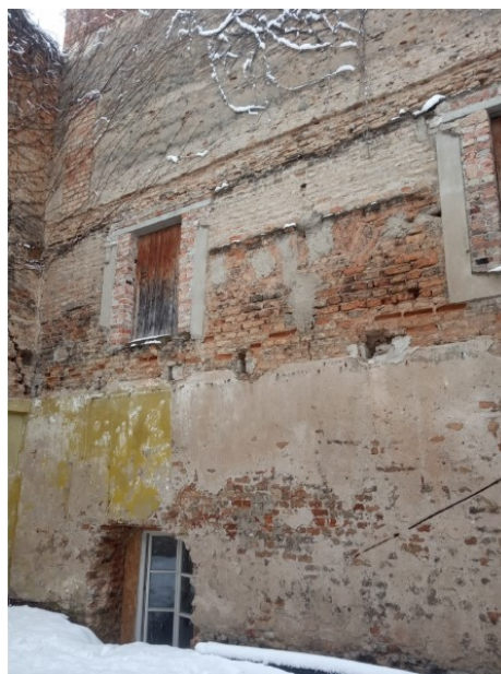
Pirmojo ūkinio pastato siena su buv. sijų lizdais ir stogo konstrukcijos žyme virš antro aukšto langų
