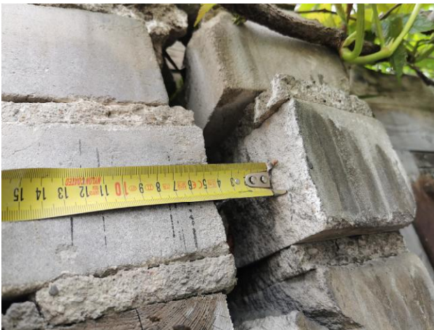
9 pav. Vertikalus plyšys ties mediniais vartais plotis iki 48 mm.
