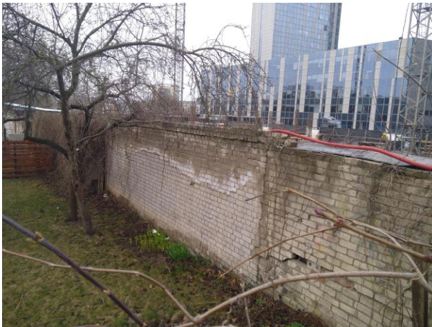
15 pav. Iš Lvovo g. 19A sklypo pusės matomi horizontalūs ir vertikalūs plyšiai (užsakovo pateikta nuotrauka).
