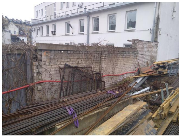
16 pav. Tvora nevienalyčio mūro, skirtingų aukščių (užsakovo pateikta nuotrauka).
