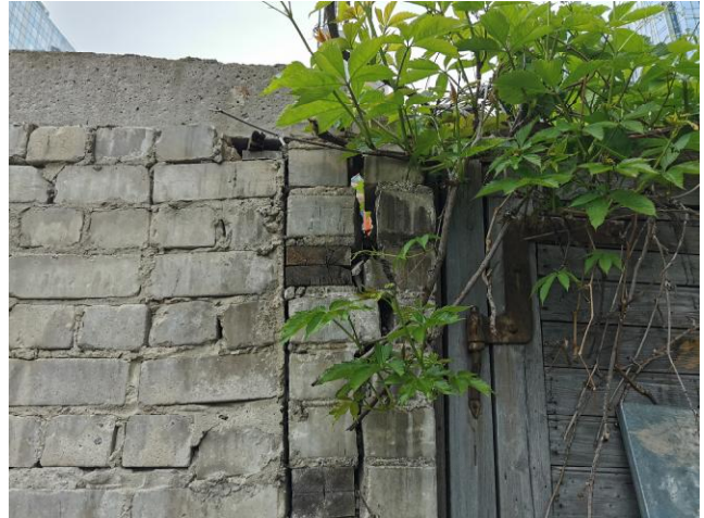
8 pav. Ties mediniais vartais matomas vertikalus plyšys tvoros mūre.
