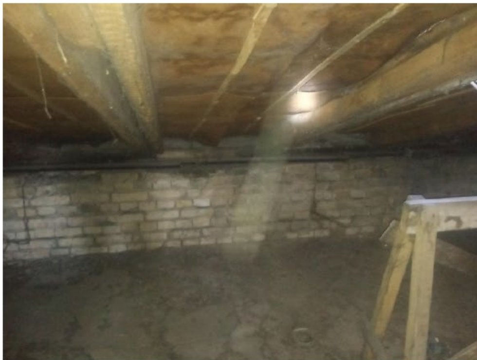
F 9 Pastato Šaltinių g. 7 mūrlotai pakeisti XX a. II p. etape, nežymiai (apie 20 cm) pažeminant mūrloto lygį
