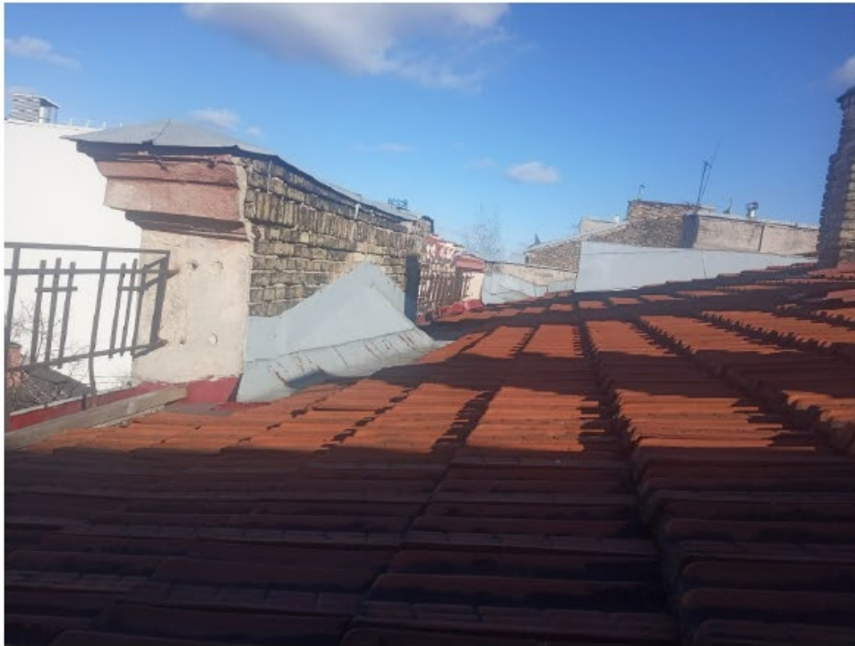
F 11 Pastato Šaltinių g. 7 stogo danga pakeista iš skardos į čerpių XX a. II p. etape. Parapetinė metalinė tvorelė įrengta XX a. II p. etape.
