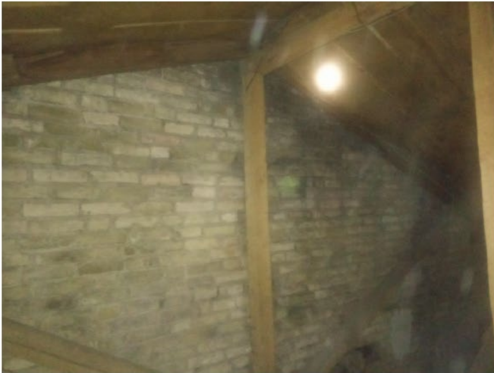
F 7 Pastato Šaltinių g. 7 stogo konstrukcija (pakeista XX a. II p. etape) glaudžiasi prie XX a. pr. etapo kamino
