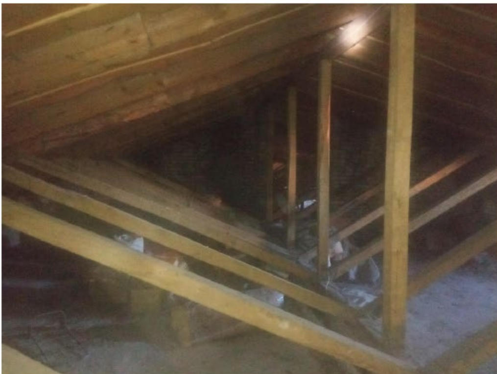
F 6 Pastato Šaltinių g. 7 stogo konstrukcija buvo ištiesai pakeista XX a. II p. etape.
