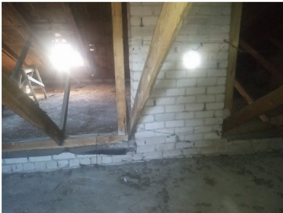
F 10 Pastato Šaltinių g. 7 vidinė išilginė siena ir stogo konstrukcijos statramsčiai ir spyriai pakeisti XX a. II p. etape
