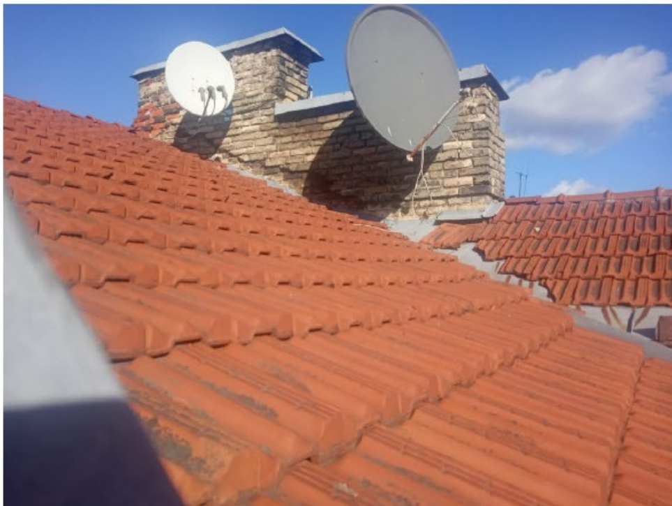
F 12 Pastato Šaltinių g. 7 kamino užkarpa žymi nežymiai (apie 20 cm) aukštesnį stogo lygį pirminiame XIX a. pab. - XX a. pr. istorizmo etape.
