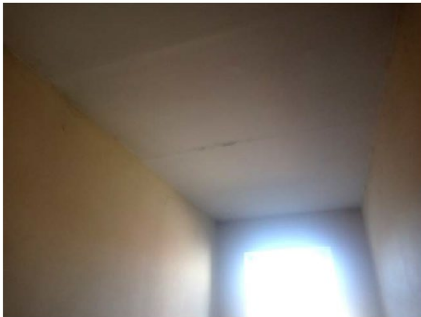
F 4 Pastato Šaltinių g. 7 bendros laiptinės perdanga – XX a. II p. surenkamo gelžbetonio plokščių
