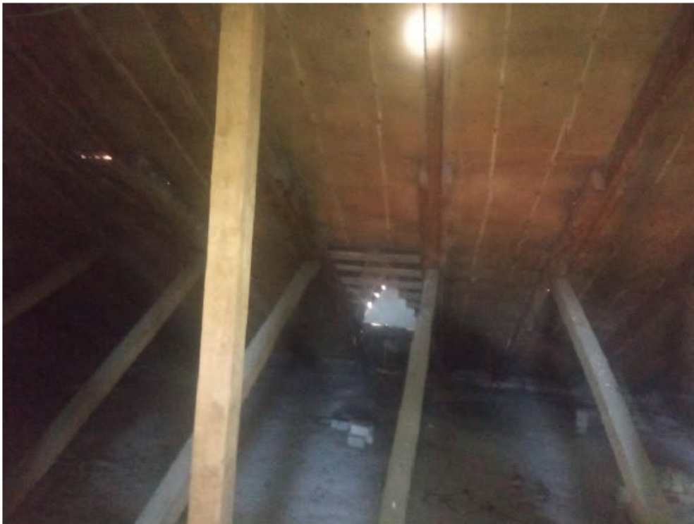
F 8 Pastato Šaltinių g. 7 stogo konstrukcija ir trikampiai tūriniai stoglangiai pastogės Vėdinimui - XX a. II p. etapo
