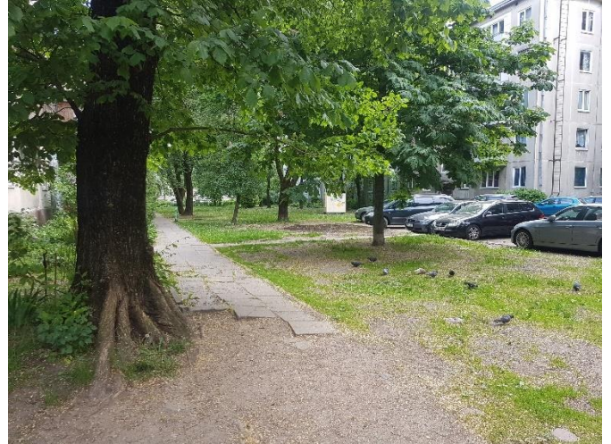
Esamo šaligatvio būklė ties Naugarduko g. 49
