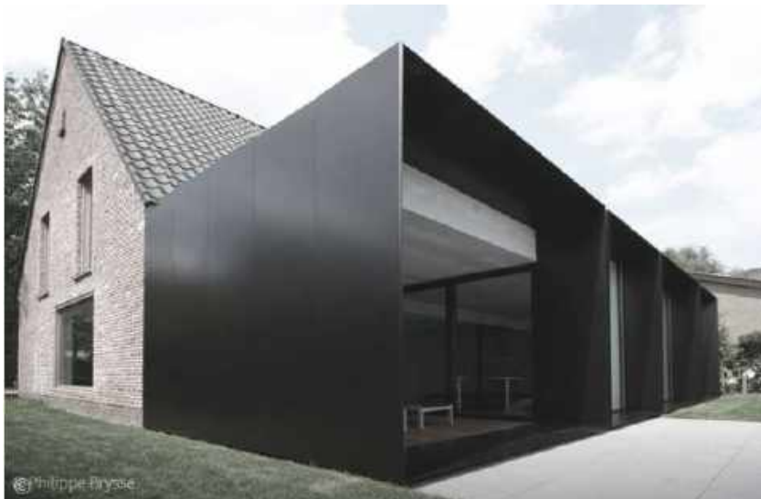
House ds/graux& / BAEYENS architecten
