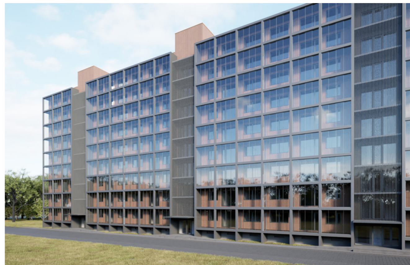
Vizualizacija: H. Balkonų ilgio padidinimas per iki 9 m (per 3 patalpas), gylis padidinamas nuo 100 cm iki 150 cm
