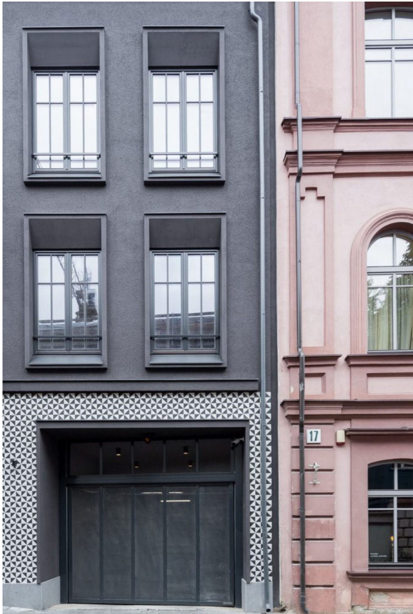
Kokybiškai atliktas tamsus tinkuoto fasado pavyzdys, daugiabutis pastatas Vilniaus senamiestyje, Aketuri architektai (fot. aut. Norbert Tukaj) https://www.aketuri.lt/project/subaciaus-st-19/
