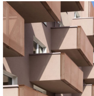
Ažūriniai balkonų turėklai, pagaminti iš smulkiai perforuotos skardos, SCH Housing An Den Schichtgründen, trans_city TC architektai (fot. Daniel Hawelka 2020)
