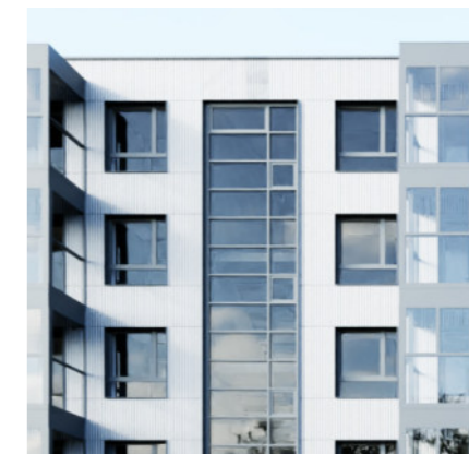
Vizualizacija: laiptinės fasadas pilnai įstiklinamas fasadine aliuminio sistema
