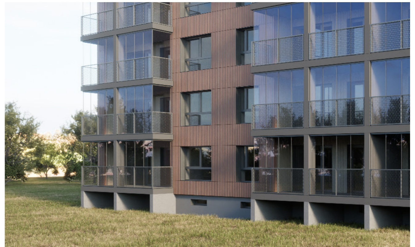
Vizualizacija: atviro tipo permatomas turėklas iš nerūdijančio plieno tinklo (9)
