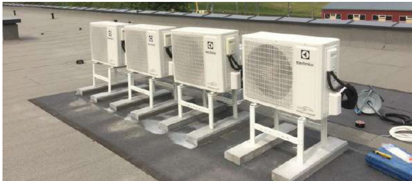
Kondicionierių lauko blokai montuojami ant namo stogo
