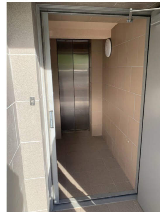
Lifto pritaikymas universaliam dizainui, devynių aukštų pastato modernizacija Žirmūnuose (fot. Vytautas Buinevičius)
