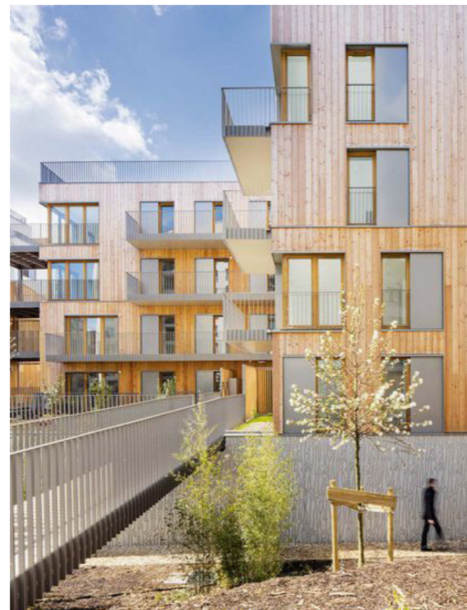
Medinių konstrukcijų daugiabutis namas Paryžiuje, Fabienne Gérin-Jean architecte (fot. Javier Callejas Sevilla, 2018)
