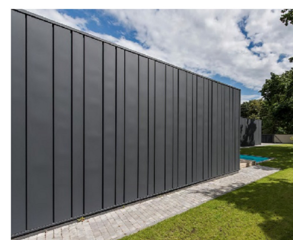
Metalinė fasado apdaila
