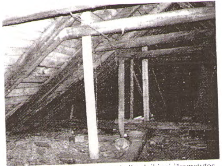
8. Linkstančios stogo konstrukcijos laikinai išramstytos statramsčiais.
