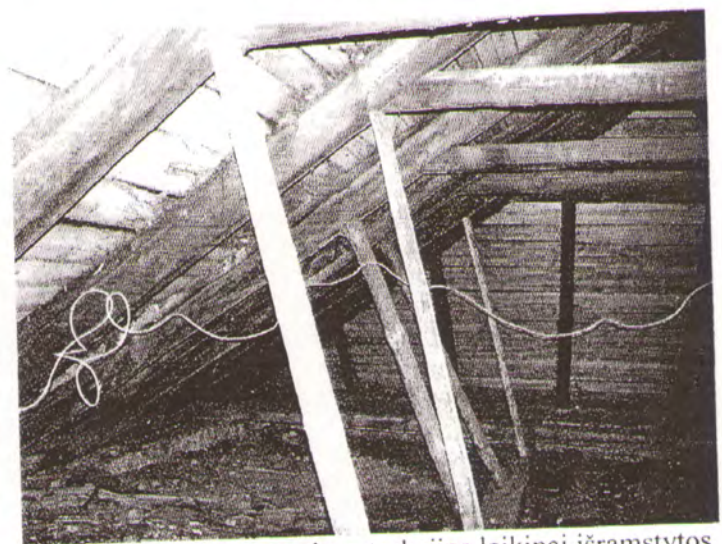
12. Linkstančios stogo konstrukcijos laikinai išramstytos statramsčiais.
