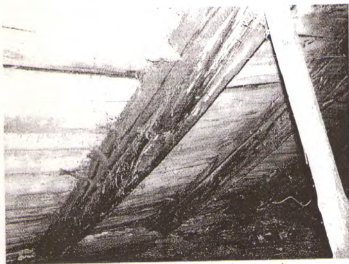
15. Puvinio pažeistos, įlinkusios gegnės.
