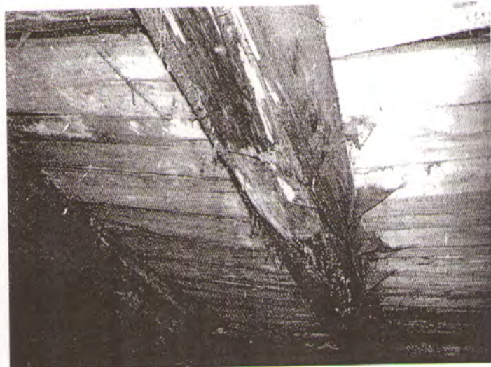
14. Puvinio pažeista, įlinkusi gegnė.
