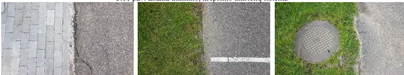
3.12 pav. Esamų dangų atskyrimo detalės, būklė
