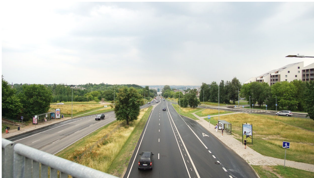
Esama būklė. Fotofiksacija nuo Ozo g. viaduko per Ukmergės g.
