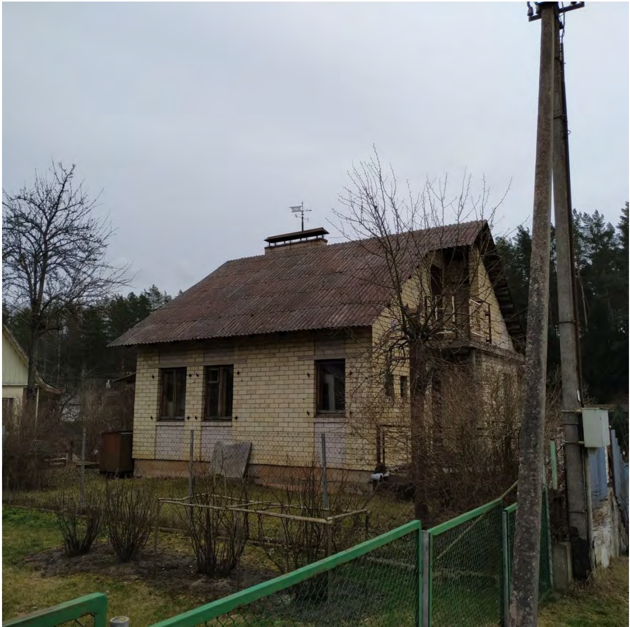
Esamo (rekonstruojamo) pastato fotofiksacija (2020 m.)
