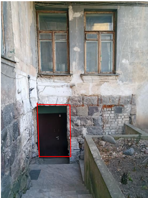
Apie 1967 m įrengiant pusrūsyje technines patalpas lango anga performinta į durų angą. (žiūr. pusrūsio inventordinį planą).
