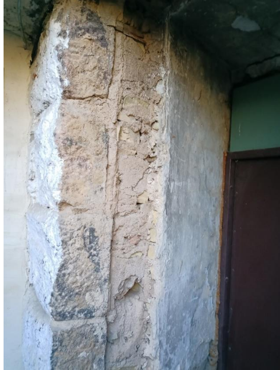
Pusrūsų mūrytas plytomis. Fasadas apdailintas pjautais akmenimis kurių aukštis 34-37 cm ilgis 37-50 cm plotis 20 cm
