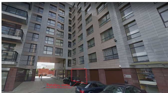
3pav. Patalpų vieta.
