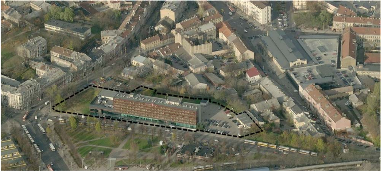
Pav. 1. Žemės sklypo Sodų g. 14 vieta
