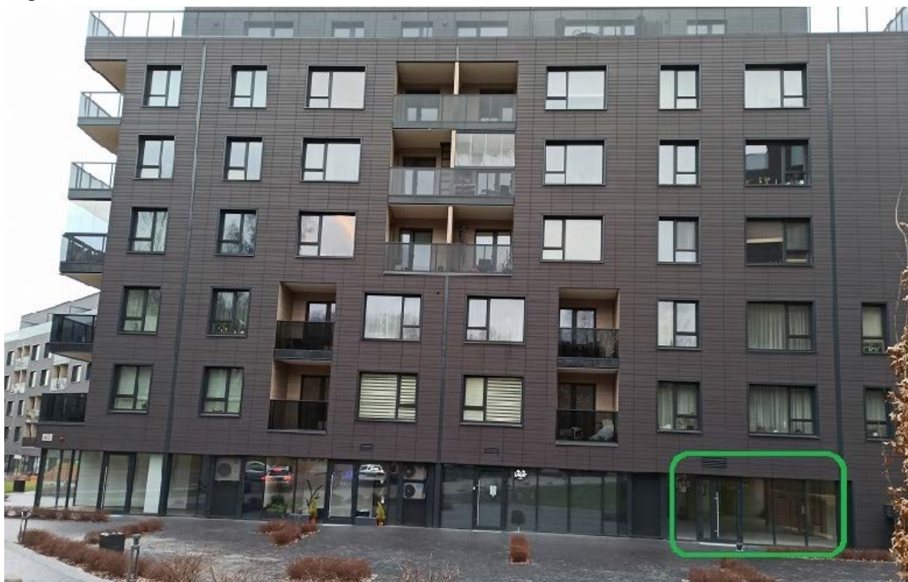
3 pav. Pastato fasadas.
