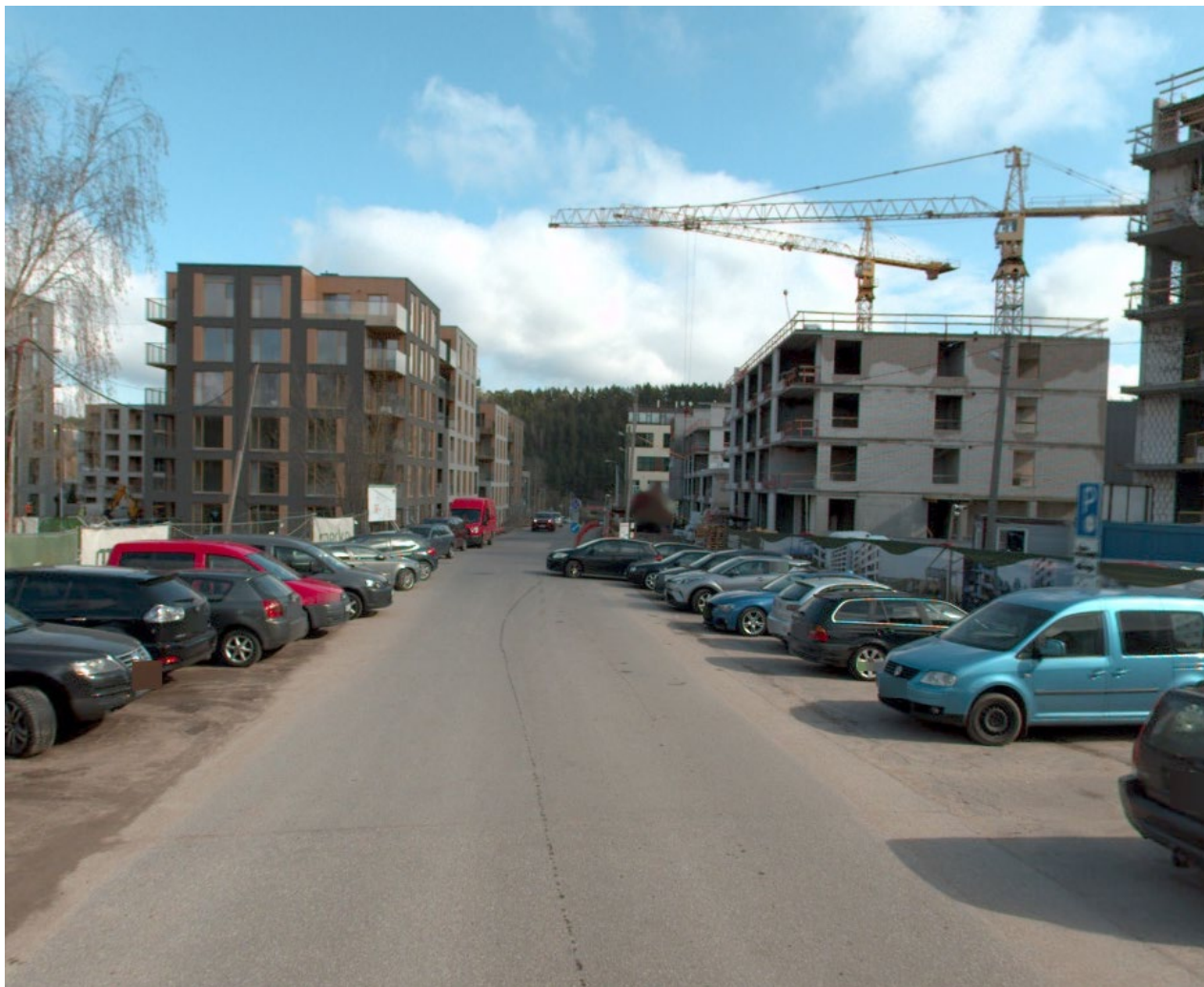
1 pav. Esama gatvės situacija
