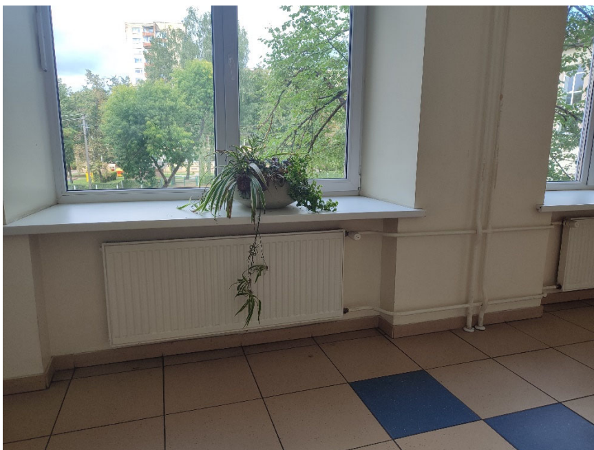
FOTOFIKSACIJA: Esamas, numatomas demontuoti radiatorius. Atviri šildymo dvivamzdės sistemos stovai
