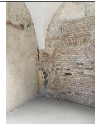
Tinko konservavimo ir atviro plytų mūro eksponavimo pavyzdžiai
