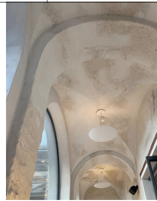
Tinko konservavimo ir atviro plytų mūro eksponavimo pavyzdžiai
