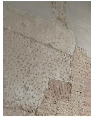
Tinko konservavimo ir atviro plytų mūro eksponavimo pavyzdžiai
