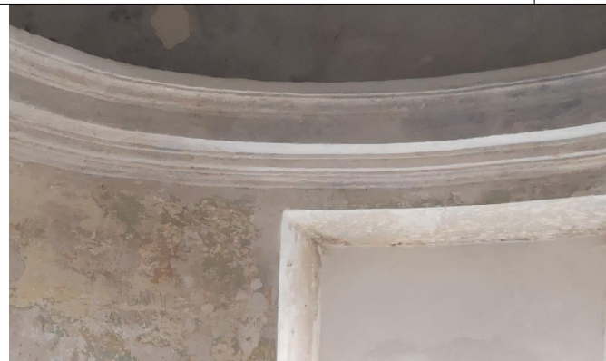
Tinkuoto plytų mūro karnizo restauravimo pavyzdys
