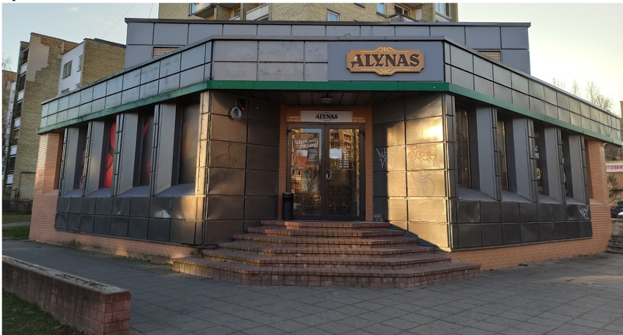
3 pav. Pastato fasadas.
