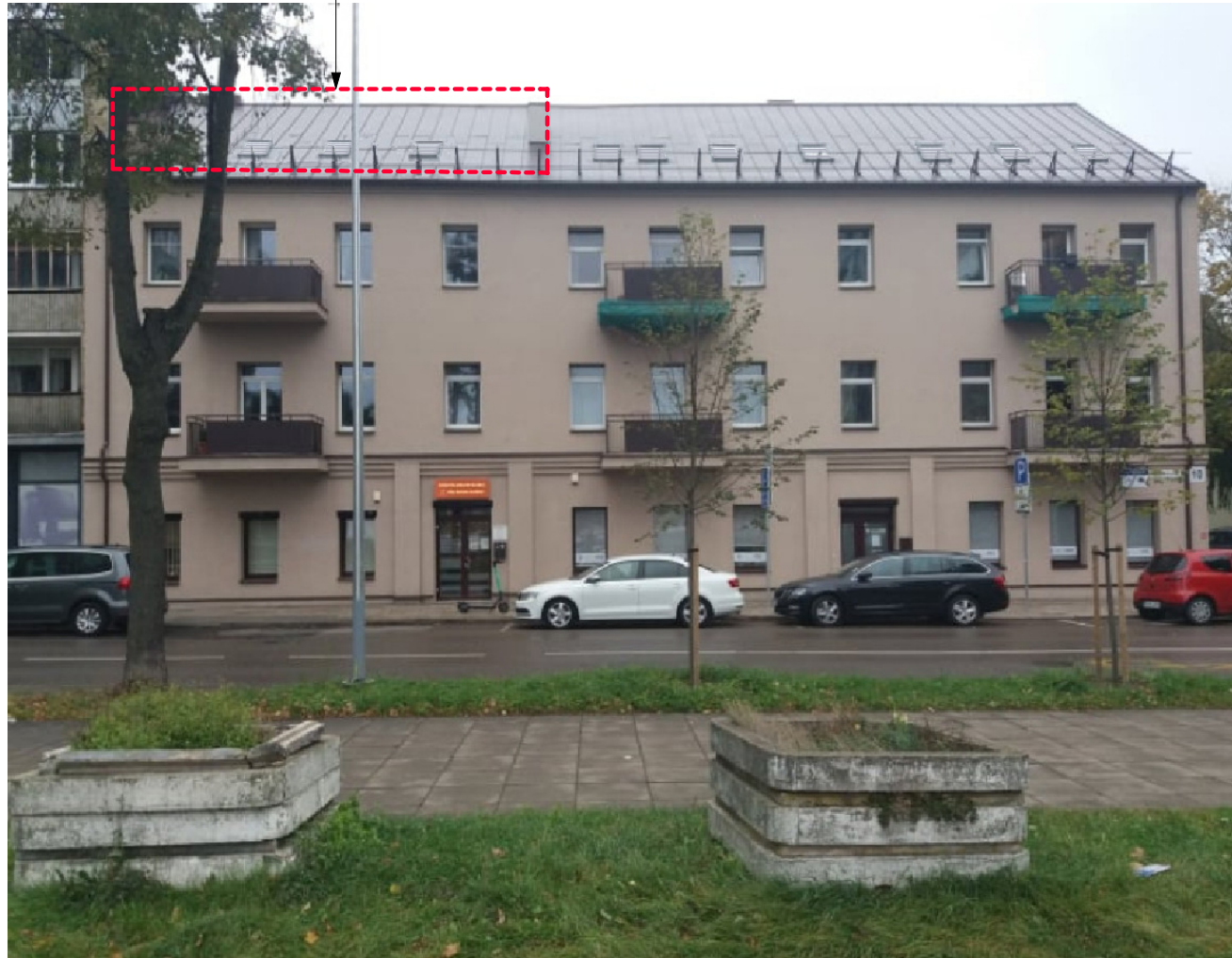
Neįrengtos pastogės Nr. 12 vieta Paskirtis keičiama į gyvenamąją (butų)
