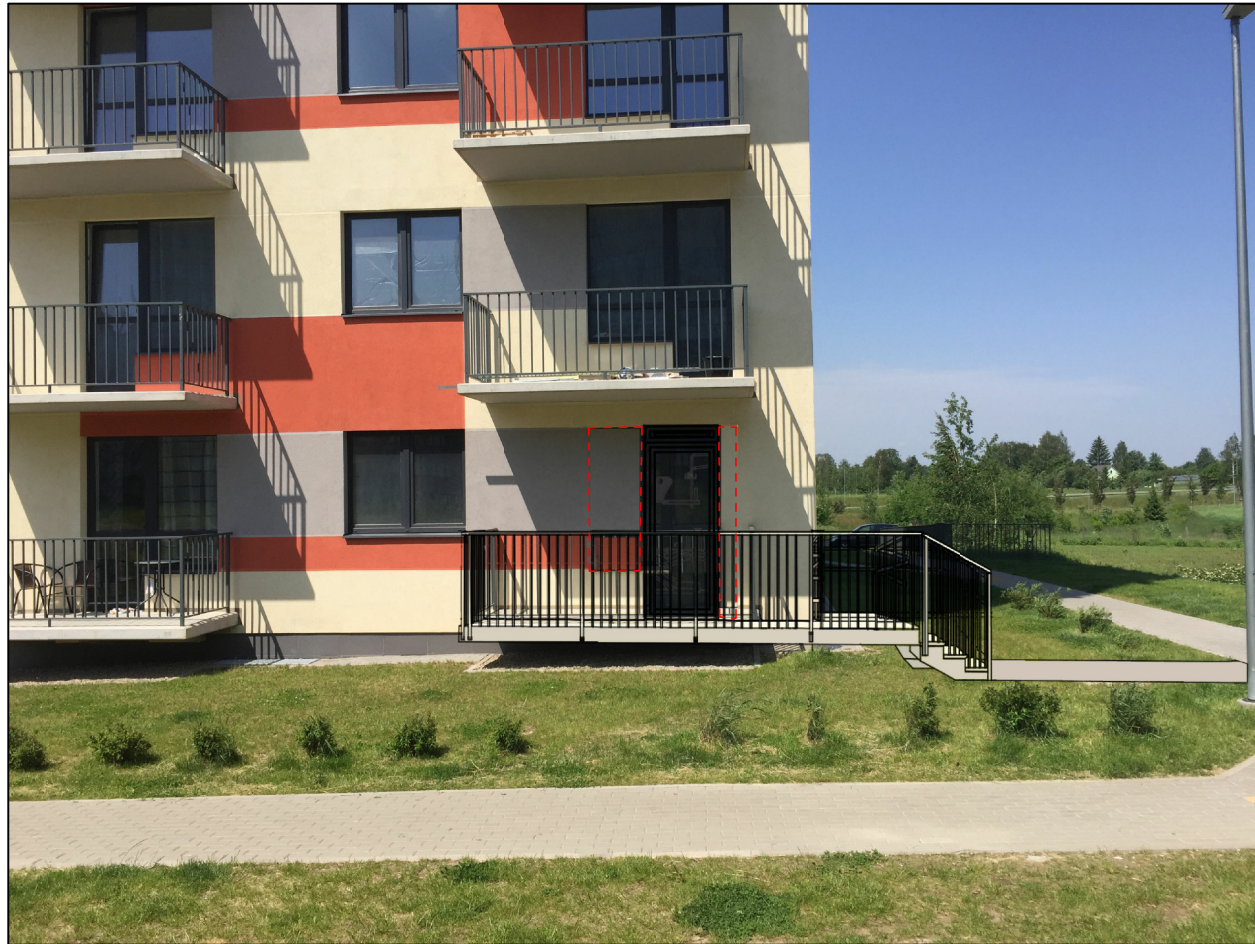
Demontuojamas 1a. langas, įrengiamos virtininės durys. Užmūrijama lango anga, atstatomas šiltinimo sluoksnis ir sienų apdaila pagal esamą spalvinį sprendinį.
