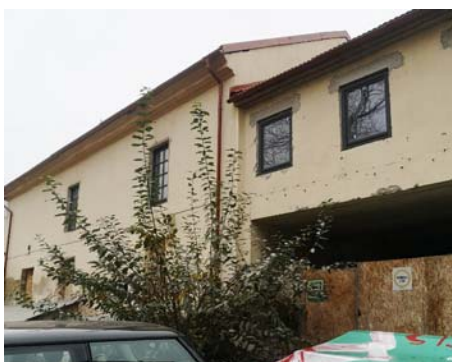
19 pav. Pastato Nr. 4 lauko fotografacija
