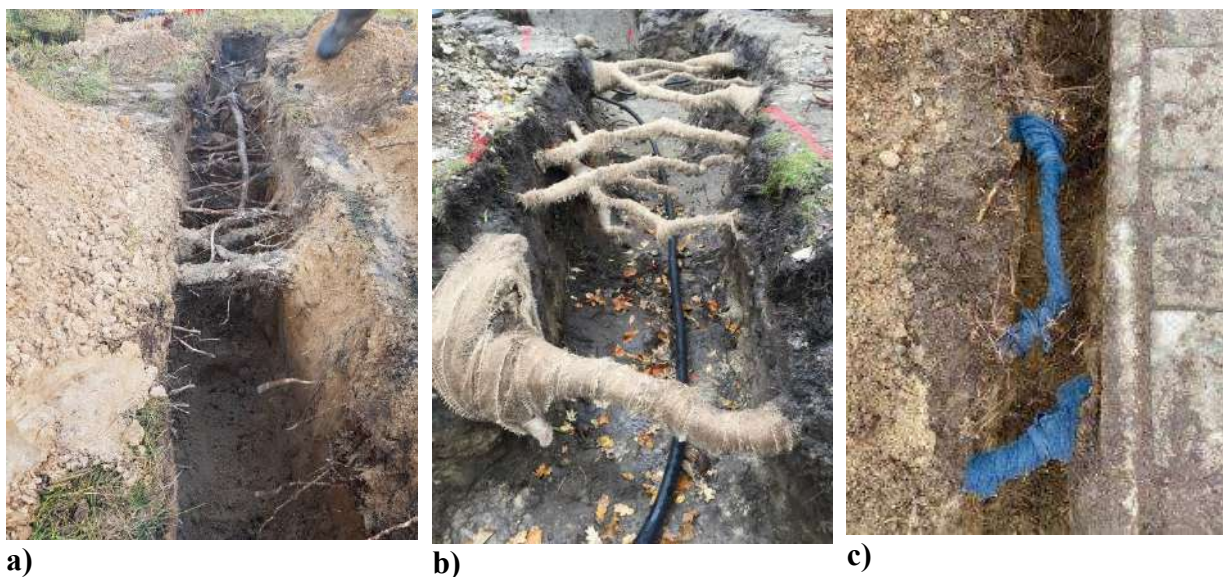
6 pav. Skeletinių ir smulkių medžio šaknų išsaugojimo kasant tranšėją arba tako, gatvės lovį pavyzdžiai.
