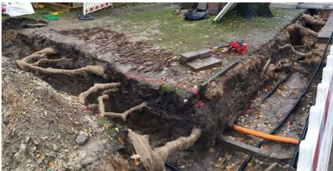
7 pav. Tranšėjos ir gatvės konstrukcijos lovio kasimo išsaugant medžių šaknis pavyzdys
