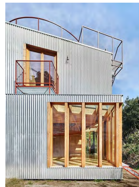
Korpusas E Cinkuota skarda, su medžio konstrukcija
