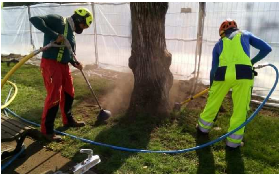
6 pav. Medžio šaknų atkasimas oro kastuvu
