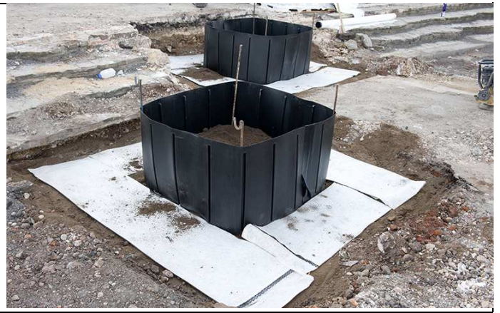
9 pav. Šaknų nukreipimo juosta. Galimas dėjimo būdas iš dviejų arba iš visų keturių pusių
