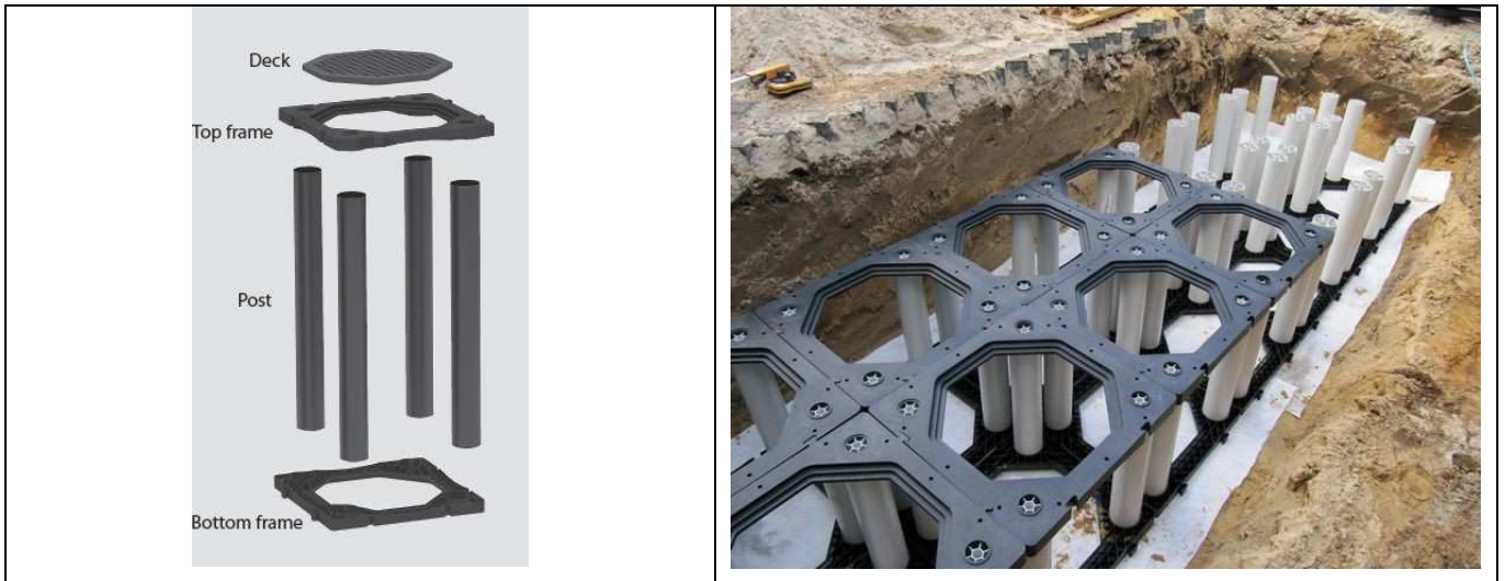
7 pav. Šaknų orinimo modulio sudėtinės dalys
