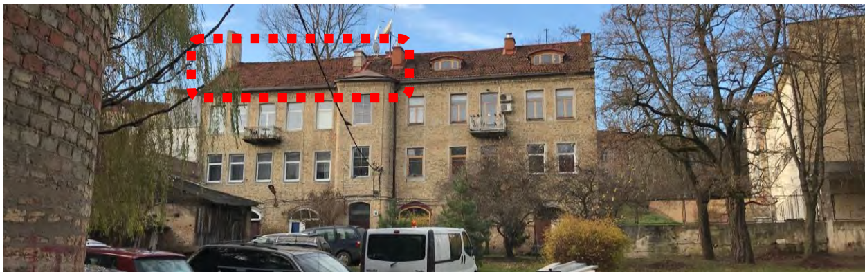
Pietryčių fasdas ( - remontuojama pastogės dalis)
