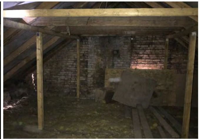
Pastogės patalpų fotofiksacija (esama situacija)
