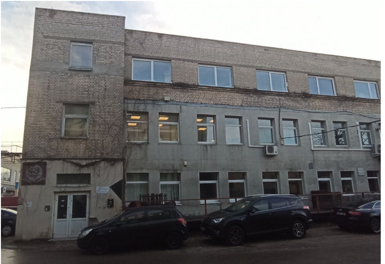
3 pav. Pastato fasadas.
