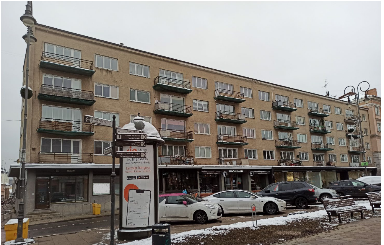
4 pav. Pastato fasadas.
