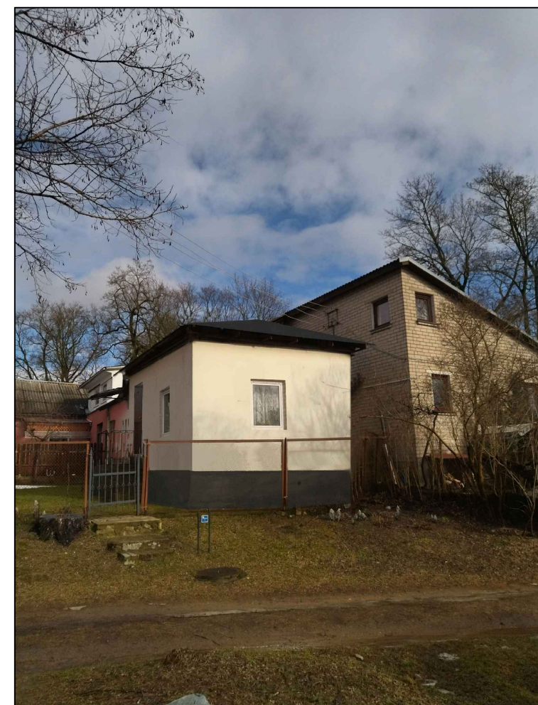
REKONSTRUOJAMA PASTATO DALIS - BUTAS NR.4
