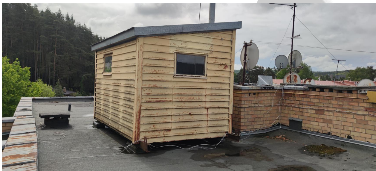
Pav. Nr. 1. Demontuojamos konteinerinio tipo AB Vilniaus šilumos tinklai priklausančios dujinės katilinės.
