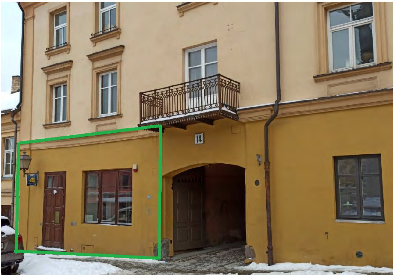
4 pav. Patalpos vieta pastate. Patalpos yra pastato pirmame aukšte.
