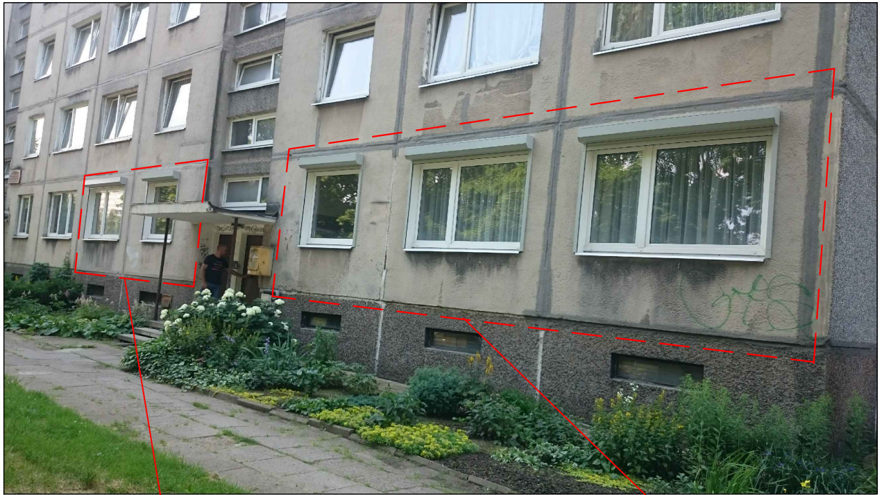
REMONTUOJAMAS BUTAS NR. 46
