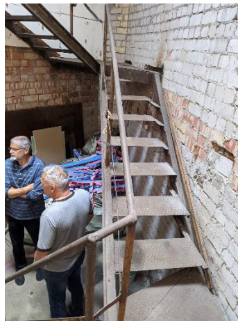
Pav. 17. Avarinės laiptinės fotofiksacija
