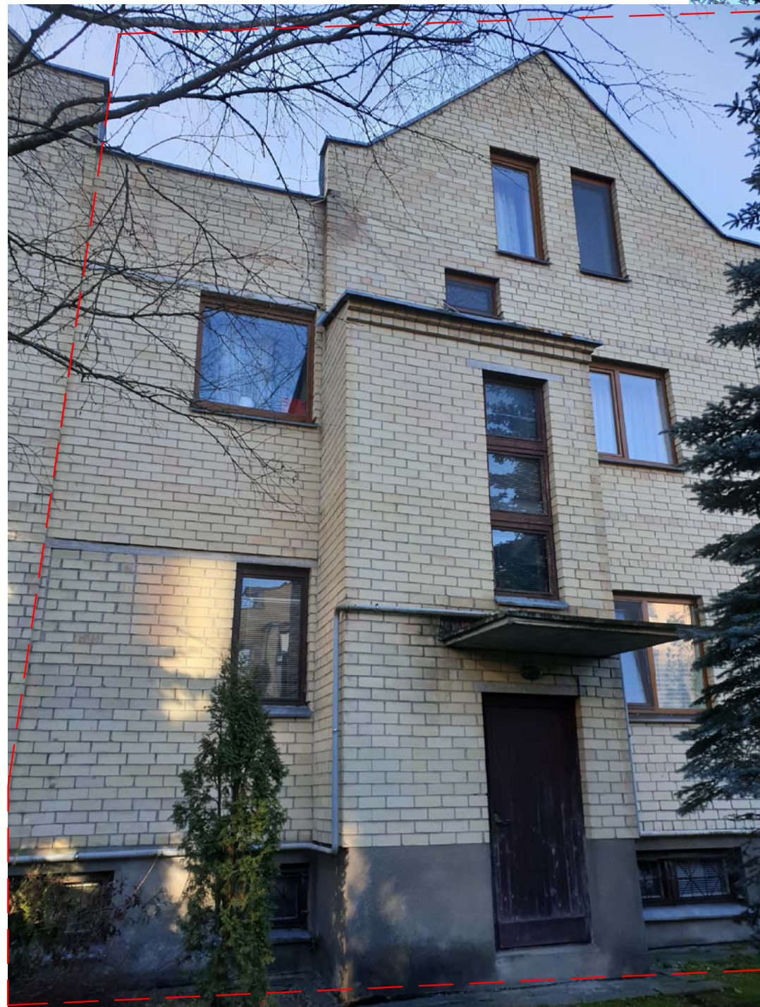
— — — — — Nagrinėjimų patalpų vaizdas iš šiaurinės pusės (iš kiemo pusės)
