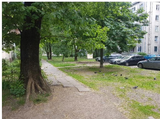
Esamo šaligatvio būklė ties Naugarduko g. 49
