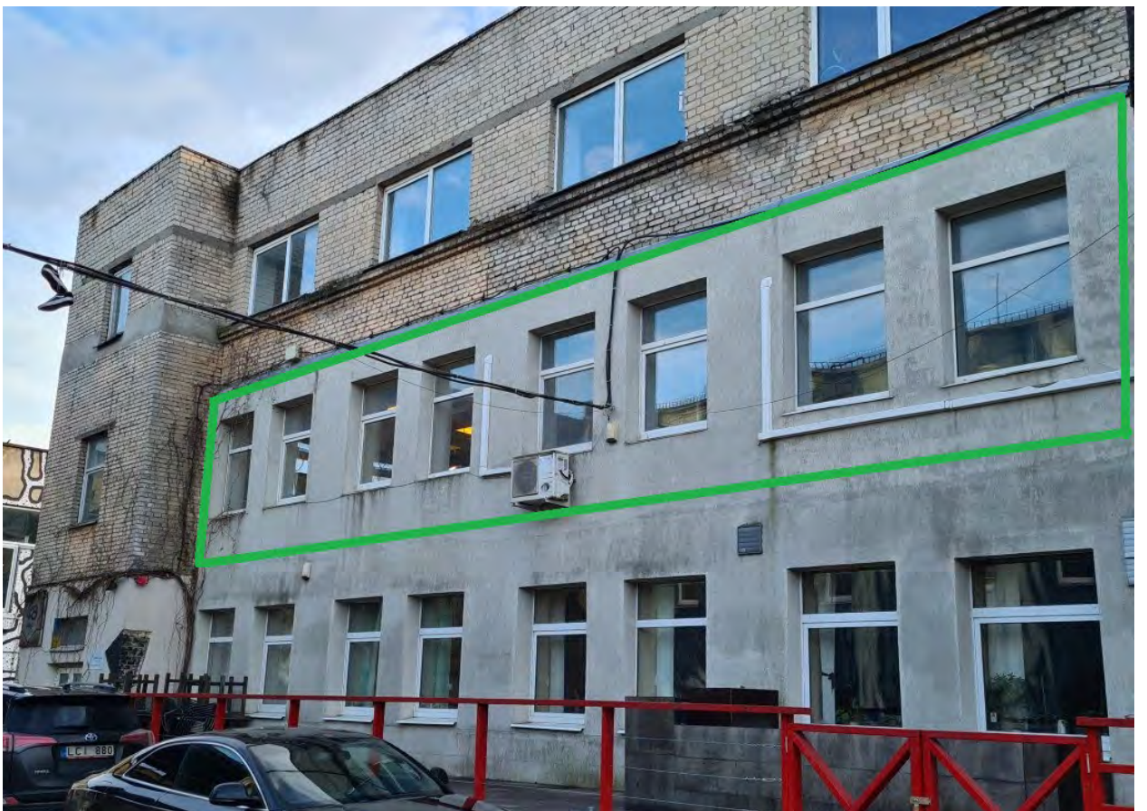
4 pav. Patalpų vieta pastate. Patalpos yra pastato antrame aukšte.
