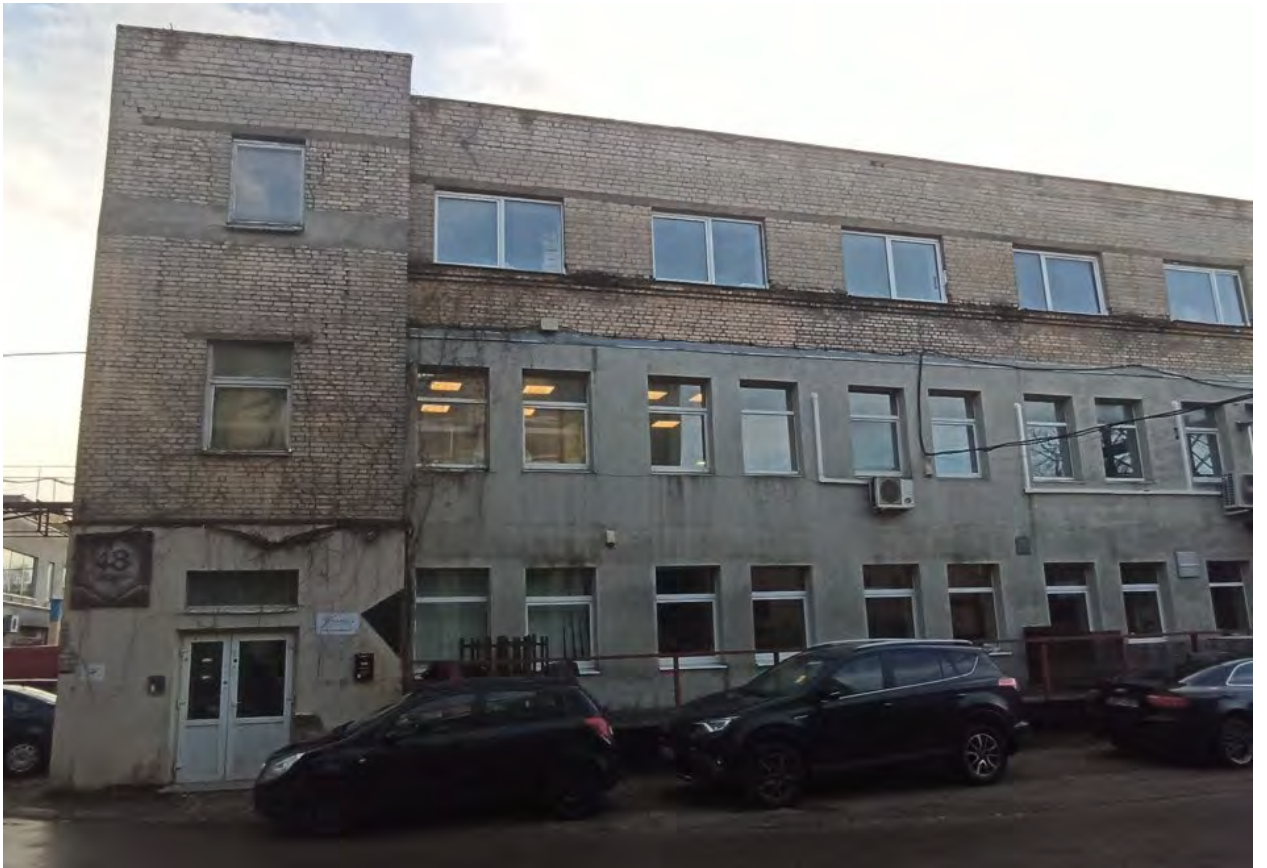
3 pav. Pastato fasadas.
