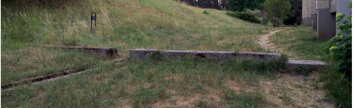
Pav. nr. 8: fotofiksacija Nr. F7, 2018-06-21. Šalintinas esamas betoninis atitvaras.
