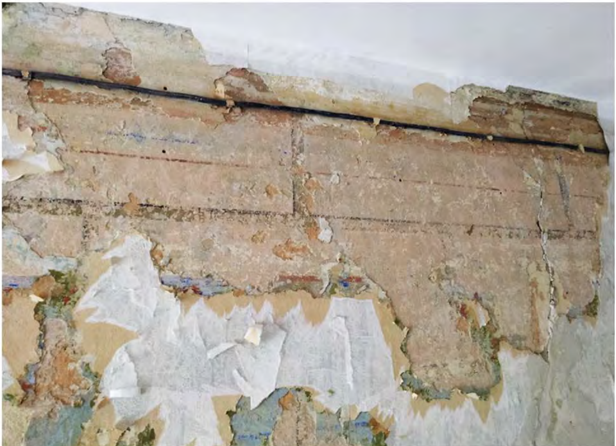
Fot. 6 Patalpa Nr. 3-4 7 sl. rustų dekorų fragmentas ant Š sienos
