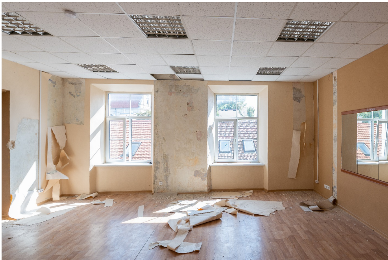
Patalpa 3-41- šalinamos pakabinamos lubos, viršutinė sienų apdaila – tapetai šalinami.
