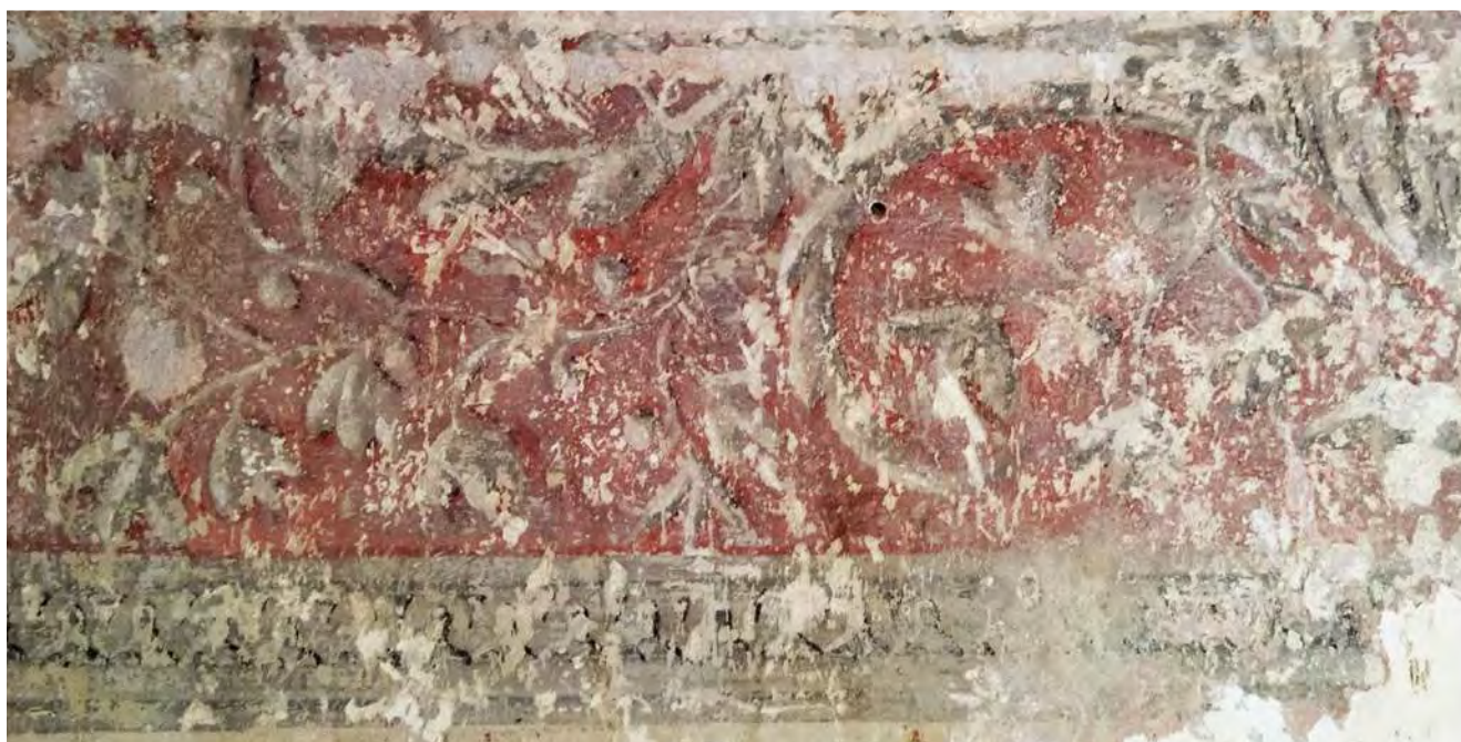
Fot. 8 Patalpa Nr. 3-5 Frizo atodangos fragmentas
