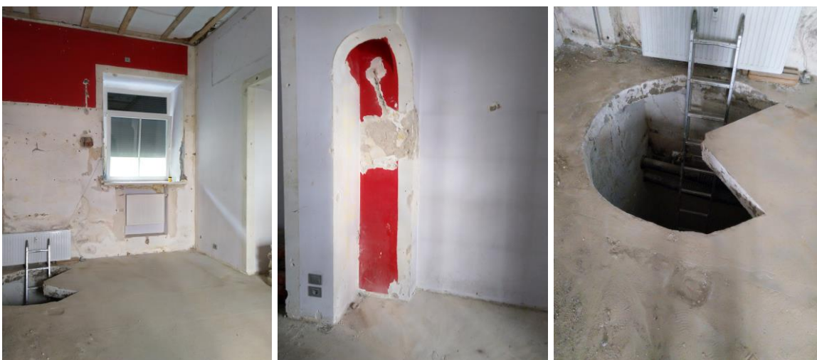
8-10 pav. Pirmo aukšto patalpos fotofiksacija (2022 m.)
