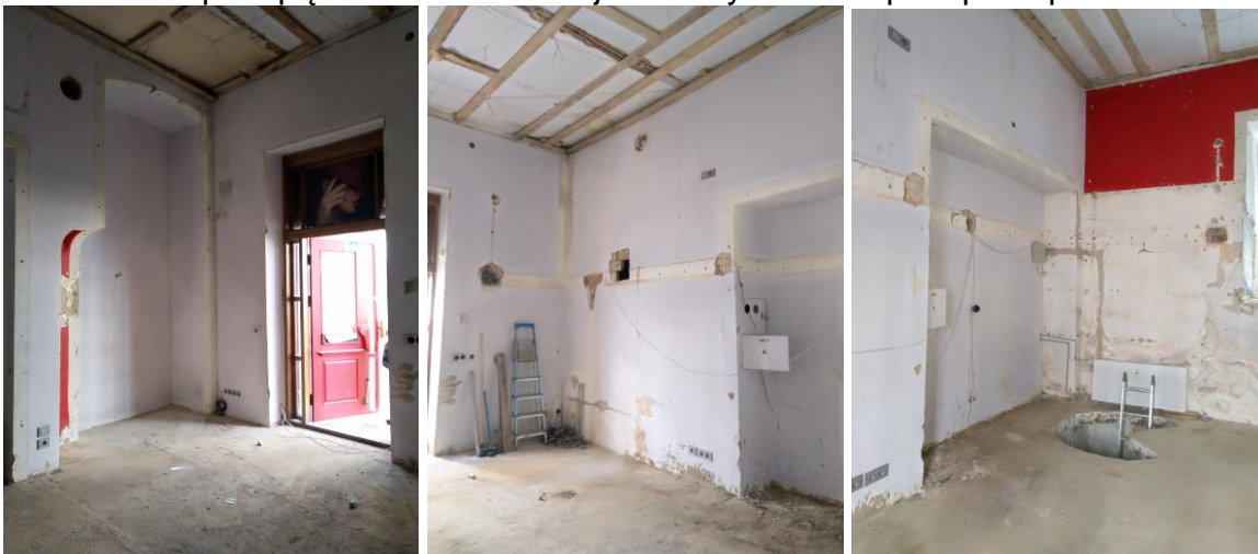
5-7 pav. Pirmo aukšto patalpos fotofiksacija (2022 m.)
