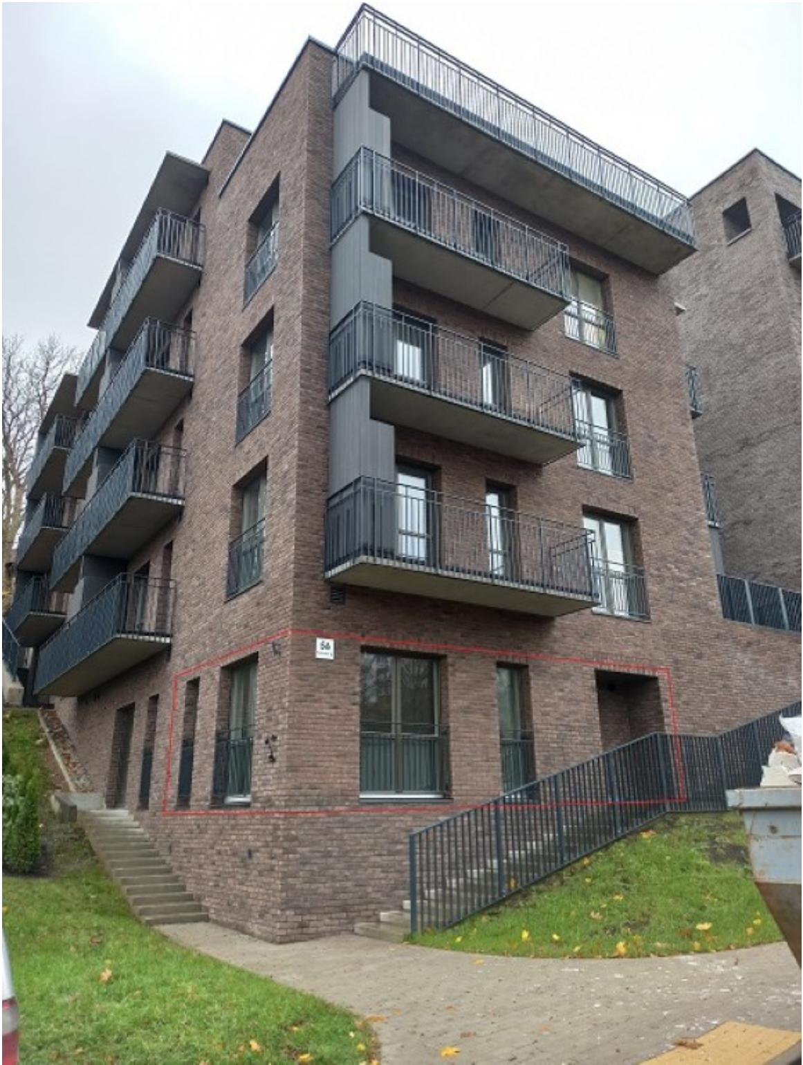
3 pav. Pastato fasadas.
