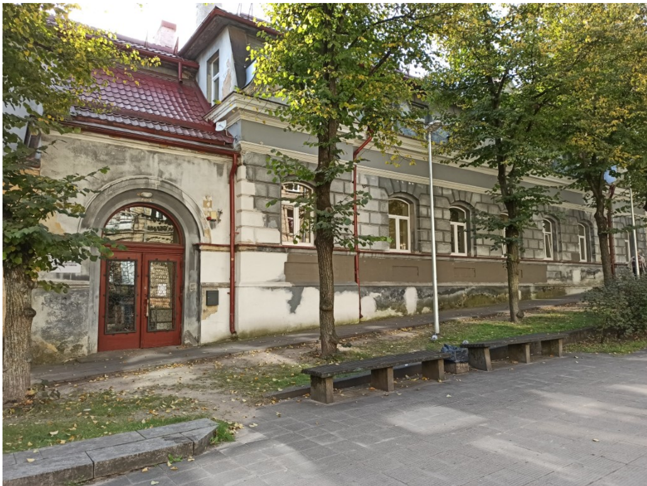
3 pav. Pastato fasadas.
