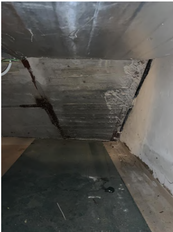
Esamos situacijos fotografacija. Esama stogo konstrukcija viešbučio dalyje. Stogas - GB konstrukcija
