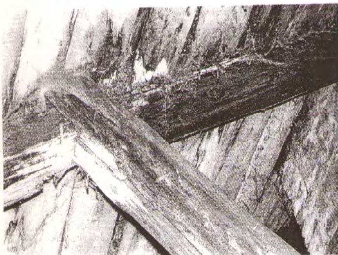
17. Puvinio pažeistas gegnės ir statramsčio mazgas.
