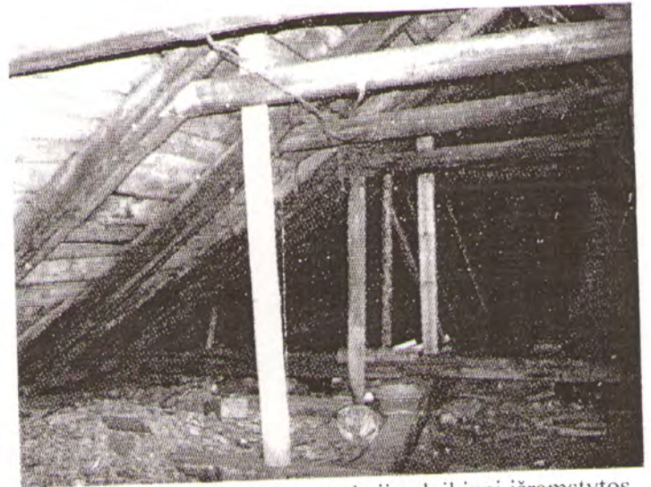
8. Linkstančios stogo konstrukcijos laikinai išramstytos statramsčiais.
