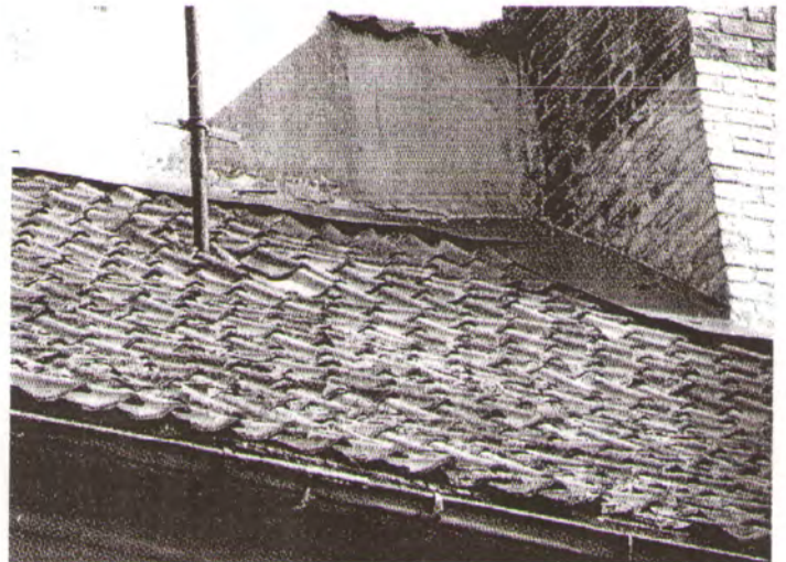
22. Susidėvėjusi čerpių danga, matomi stogo įlinkiai.
