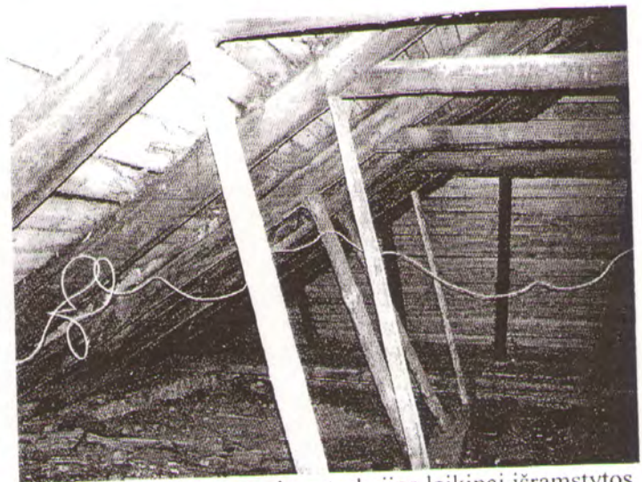
12. Linkstančios stogo konstrukcijos laikinai išramstytos statramsčiais.
