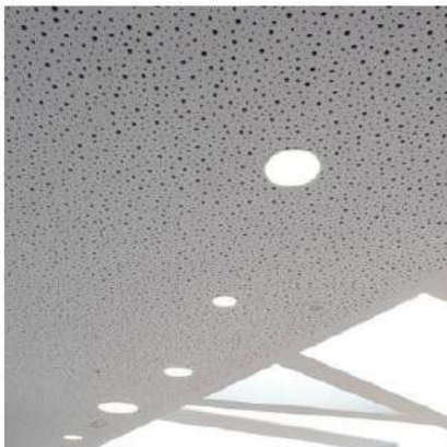
Lubos. Akustinis gipsas
