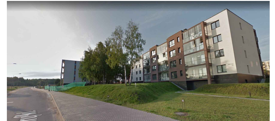
4. BAJORŲ K. 6 SKLYPE ESANTIS KOMERCINĖS PASKIRTIES PASTATAS
