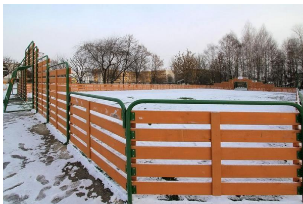
5.5 pav. Segmentinės, medinės su metaliniais elementais tvoros pavyzdys.
