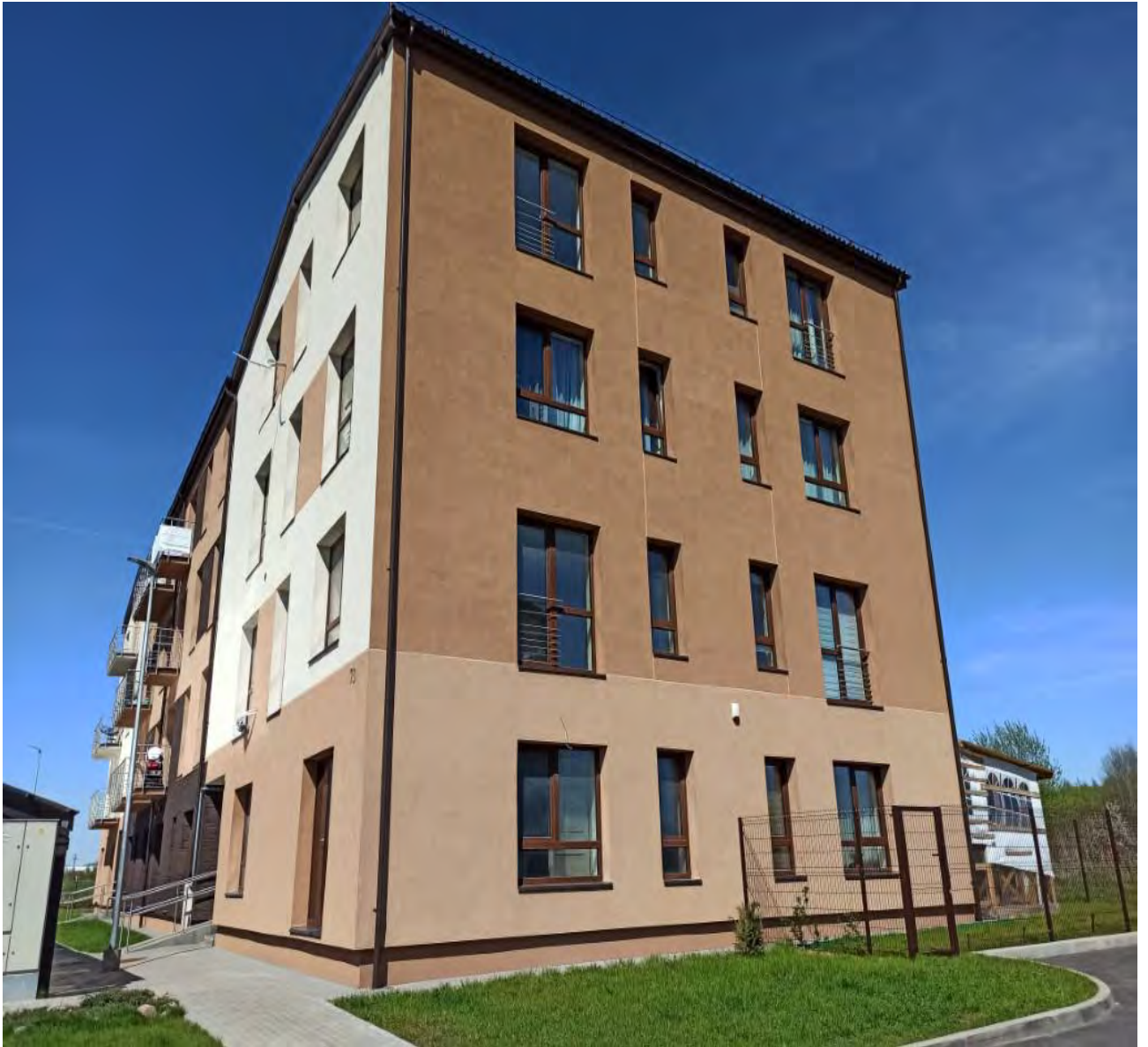
3 pav. Pastato fasadas.
