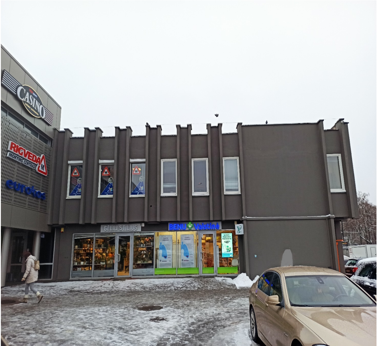
3 pav. Pastato fasadas.
