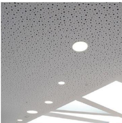
Lubos. Akustinis gipsas
