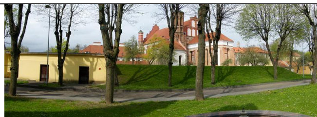
6. Vilniaus vandenvietės pastatų kompleksas
